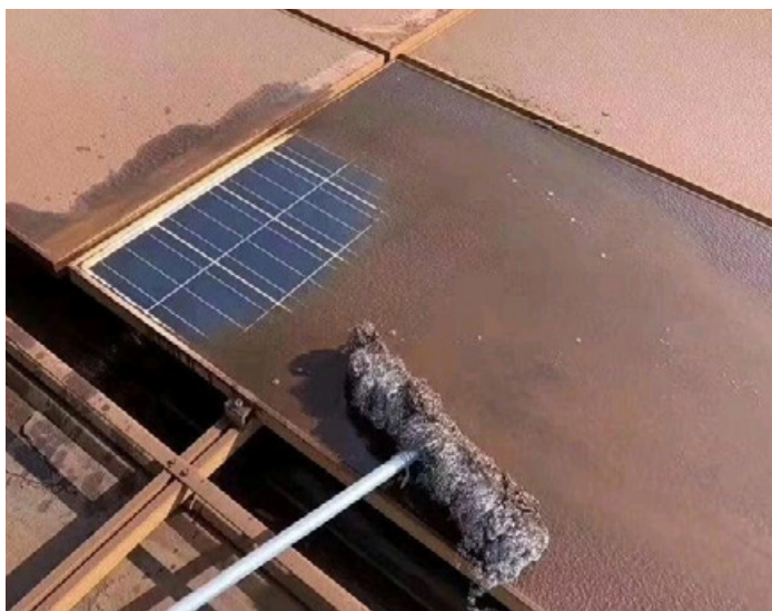
Fig. 2: Staubniederschlag auf Solarmodulen
