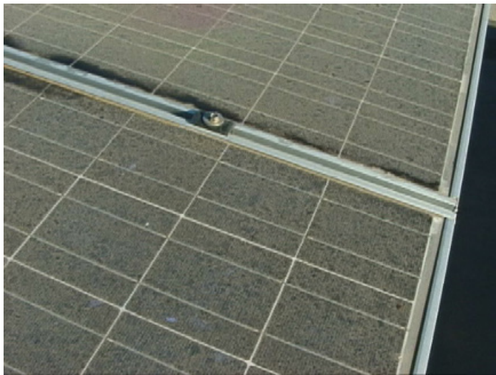
Fig. 1: Ein Beispiel für die Staubbildung auf Solarmodulen im Laufe der Zeit
