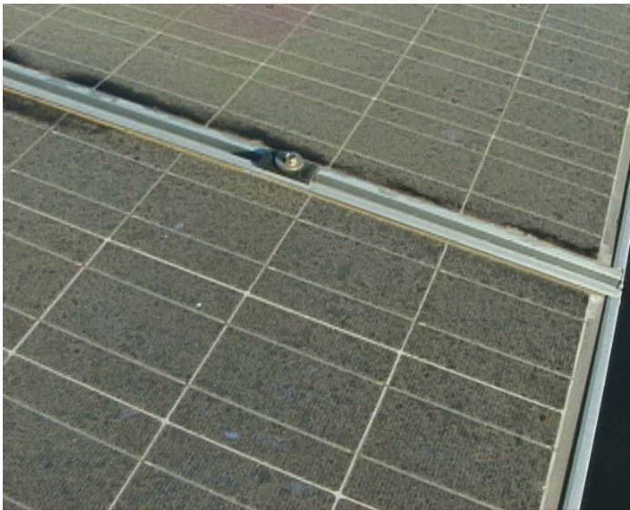
Fig. 1: Ejemplo de acumulación de polvo en paneles solares con el paso del tiempo.
