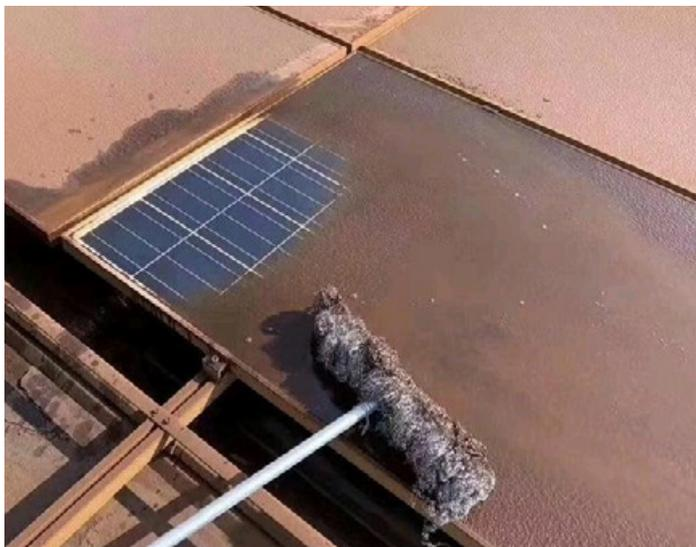
図2：ソーラーモジュールへの粉塵の降下
