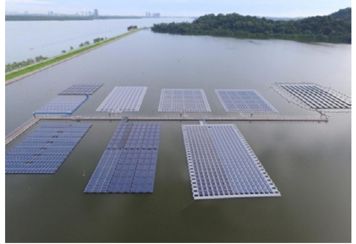
画像3：シンガポールのテンガ貯水池の1 MW フローティングPVシステム
